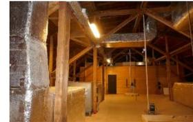
Auch die großen Klappen oberhalb der Saalbeleuchtung (LED-Paneele) sind in Form von dicken, gedämmten Klappen ausgeführt. Dazwischen gibt es immer noch Spalten, durch die warme Luft entweichen kann.
