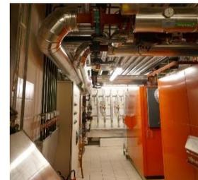
Das Gebäude wird über eine Gas-Zentralheizung mit Wärme versorgt. Einzelne Bereiche des Gebäudes können seit der Sanierung über eine zentrale Kälteanlage gekühlt werden.
